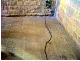
1) Vista quadrant Sudoest inici excavació
