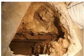
116)Vista general final excavació
