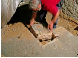
6) Extraccio lloses paviment
