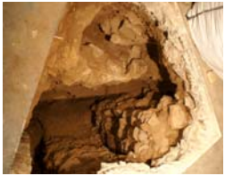
121)Vista general final excavació
