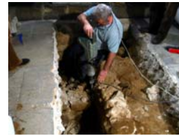
29) Afectació paret vas u.e. 215
