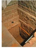
38)Vista general estructures
