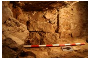
143)Vista en alçat mur u.e. 228
