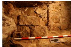
144)Vista en alçat mur u.e. 228
