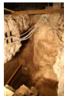
118)Vista en alçat pilastra u.e. 218
