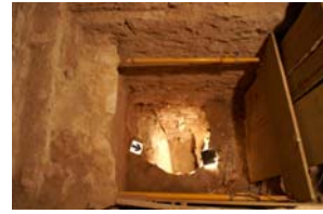
75)Vista final excavació
