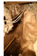
119)Vista en alçat pilastra u.e. 218
