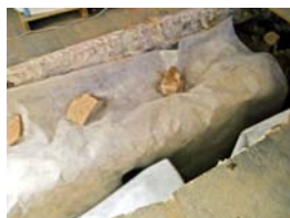
152)Protecció estructures amb geotèxtil
