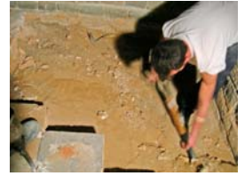
5) Extracció lloses paviment
