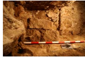
114)Vista en alçat mur u.e. 228
