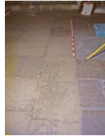
3) Lloses del paviment a extreure
