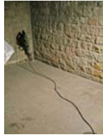
2) Vista quadrant Sudest inici excavació
