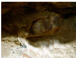
32) Detall mur u.e. 213
