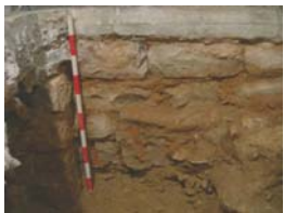
51)Sòcol u.e. 105, banqueta u.e. 110 i pilar u.e. 114
