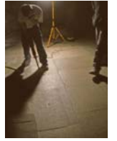
5) Extracció lloses paviment
