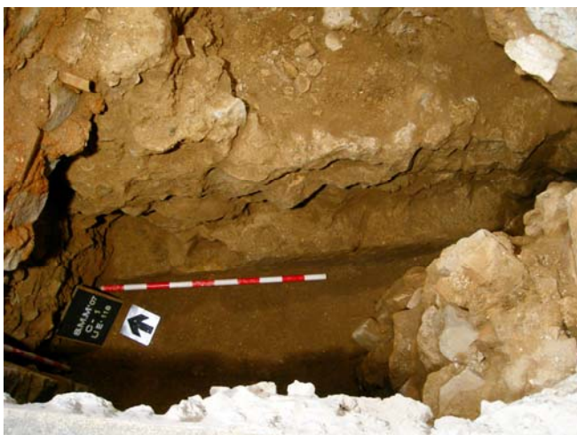
Vista del mur u.e. 118
