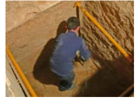
40)Sondeig al paviment u.e. 312
