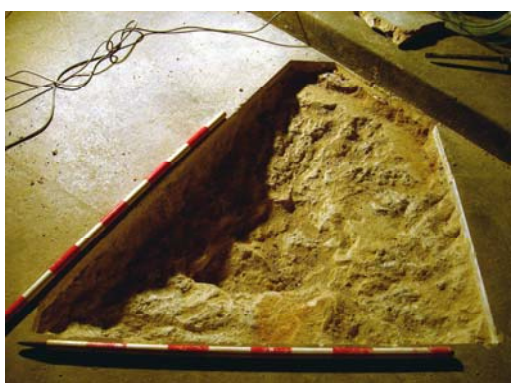
A l'esquerra vista del planxé u.e. 102 i a la dreta perfil on s'observa la seqüència de les capes de formigó
