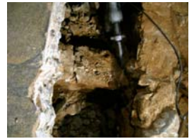
30) Afectació paret vas u.e. 215
