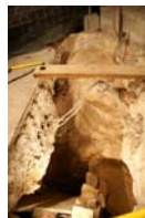
117)Vista en alçat pilastra u.e. 218
