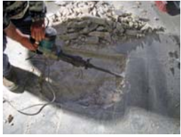
6) Extracció lloses paviment
