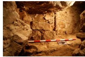
109)Vista en alçat mur u.e. 228
